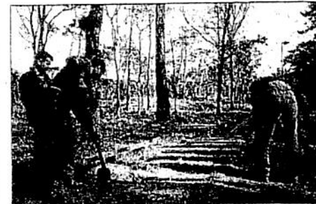
Le tramway de l'île refait ses voies, avec des traverses de bois rachetées à la SNCF.
